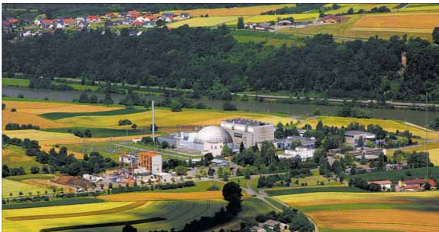
Auf- und Abbau liegen oft nahe beieinander. Während das Biomasse-Kraftwerk im Vordergrund stetig wächst, ist im Kernkraftwerk Obrigheim nun endgültig der Startschuss für den Rückbau der 2005 stillgelegten Anlage gefallen. Fotos: Heiko Schattauer
